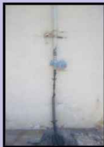
گازکشی و نصب علمک در سایت
