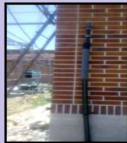
گازکشی و نصب علمک در سلف سرویس جدید
